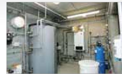
Il locale termico al piano interrato dove si trova la caldaia ad alta efficienza, il bollitore per l'accumulo di acqua calda e l'addolcitore.
