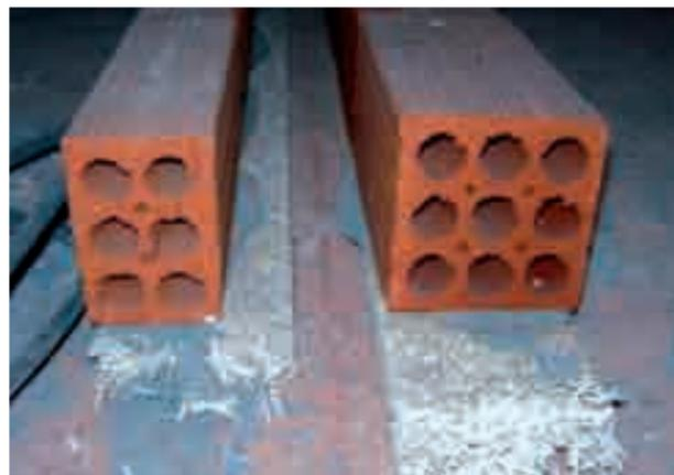
Posa di ERACLIT sotto le murature in modo da impedire contatti tra la muratura ed il solaio. Isola e attenua la trasmissione del rumore
