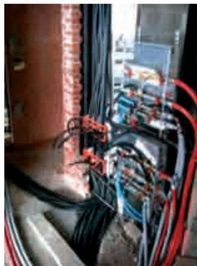
La figura illustra la messa in cantiere dei Satelliti che contabilizzano la quantità di acqua calda necessaria per il riscaldamento e gli usi sanitari.
